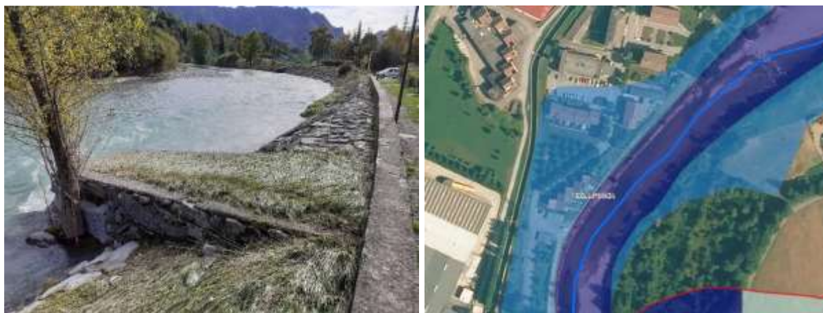
La difesa spondale in destra idrografica in località festi Rasini. Sulla destra sono presenti le villette evacuate. Nell'immagine a destra la perimetrazione delle aree allagabili del PGRA.
