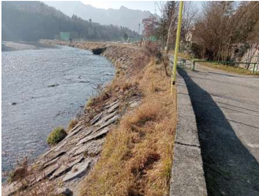
Foto 1. VISTA ZONA INTERVENTO 1 (vista verso valle)
