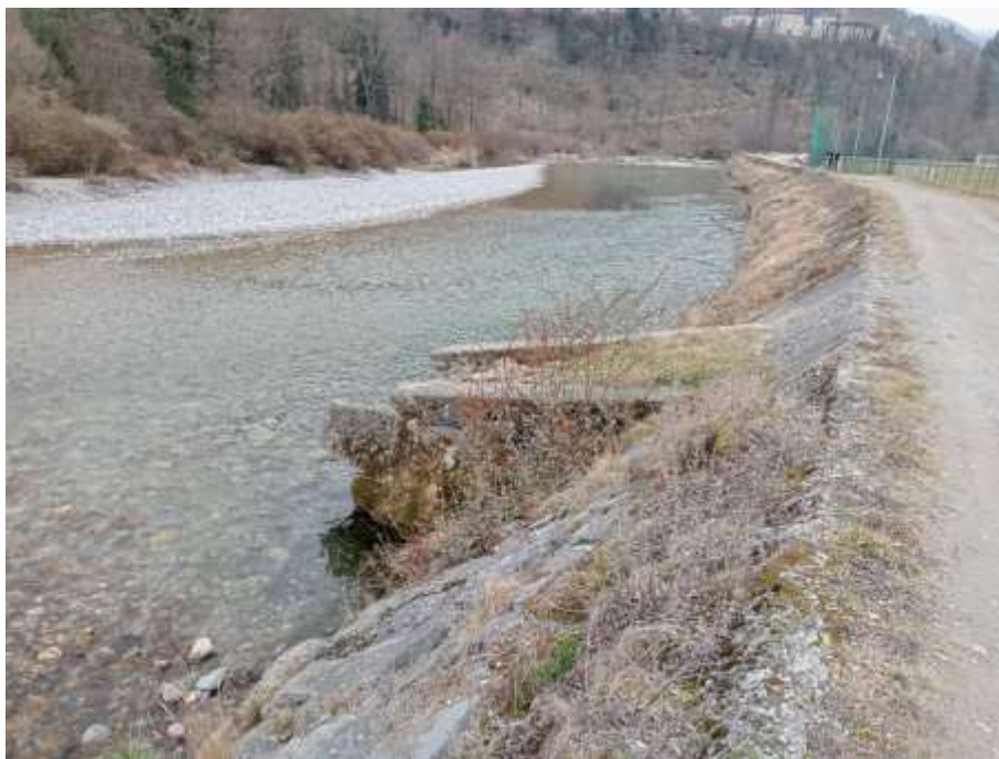
Foto 6. VISTA ZONA INTERVENTO 3 (pennello parzialmente da ricostruire)
