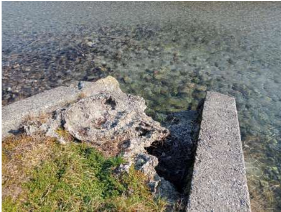
Foto 5. VISTA ZONA INTERVENTO 3 (pennello parzialmente da ricostruire)
