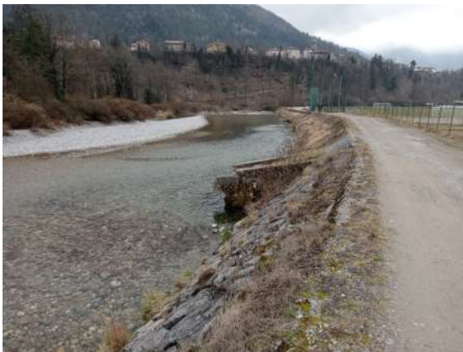
Foto 7. VISTA ZONA INTERVENTO 3 (pennello parzialmente da ricostruire)
