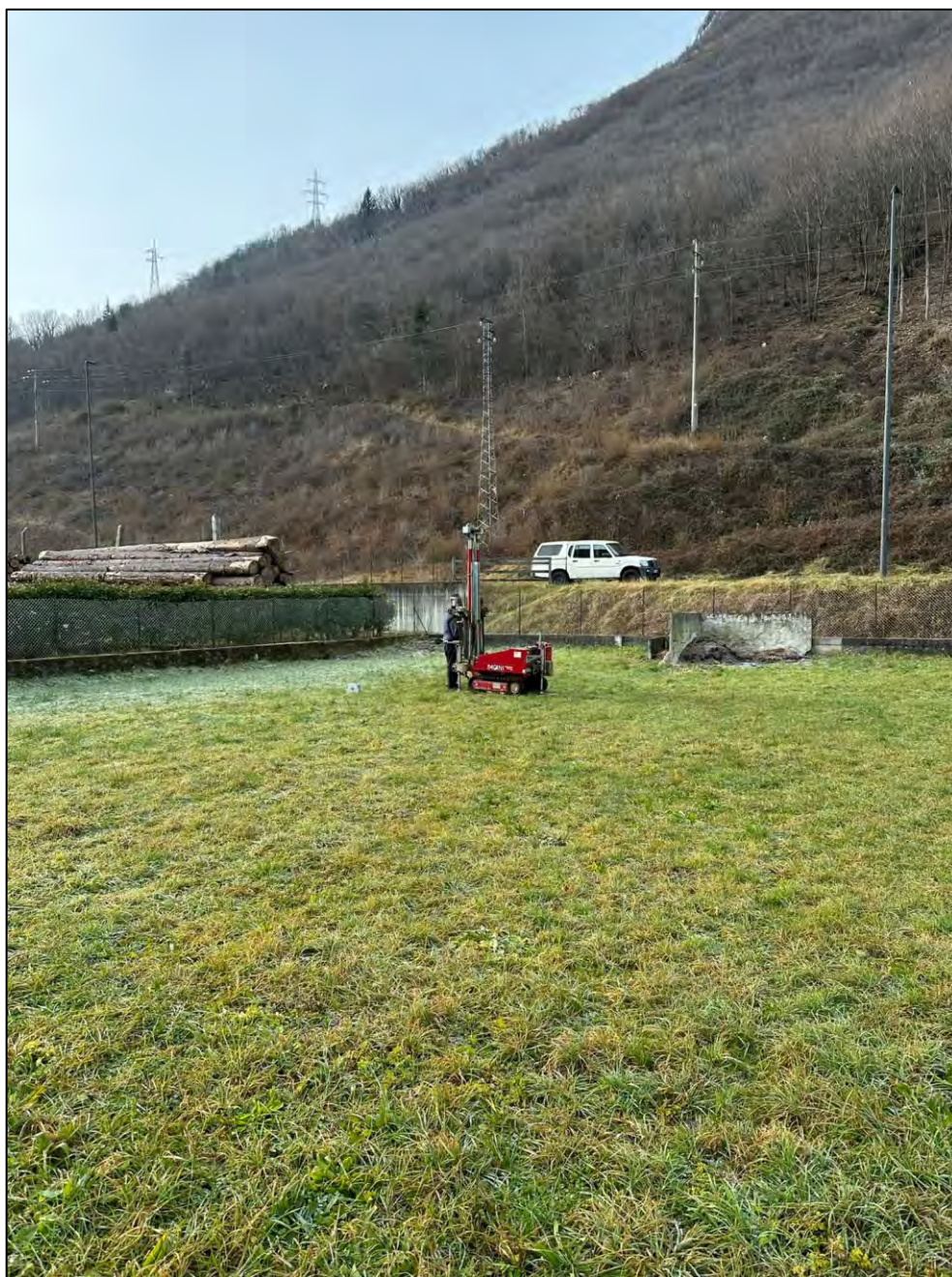
Figura 14 – Esecuzione prova PSP2
