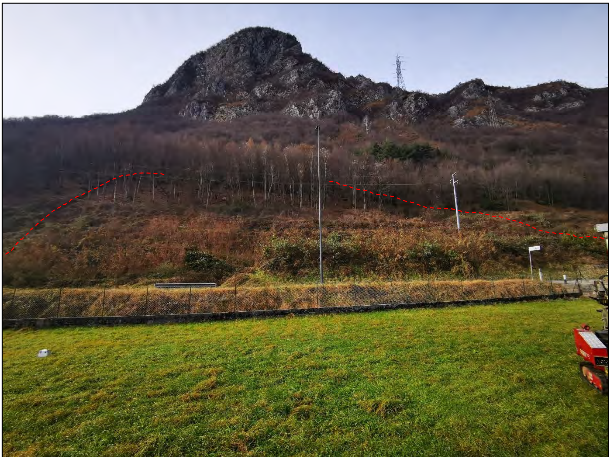
Figura 9 – Individuazione delle fessurazioni nel versante osservabili a monte dell'area di cava ricolmata
