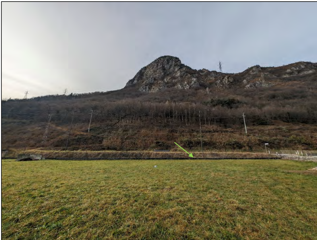
Figura 7 – Versante caratterizzato da potenziale caduta massi posto a monte dell'area di intervento. La freccia indica il vallo paramassi esistente, mascherato dalla vegetazione
