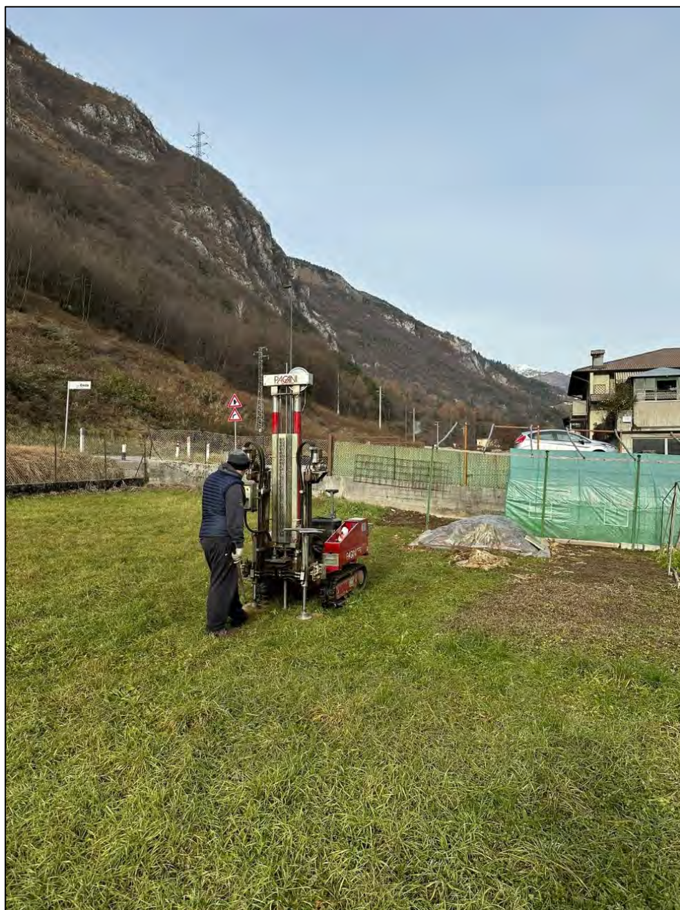
Figura 15 – Esecuzione prova PSP3
